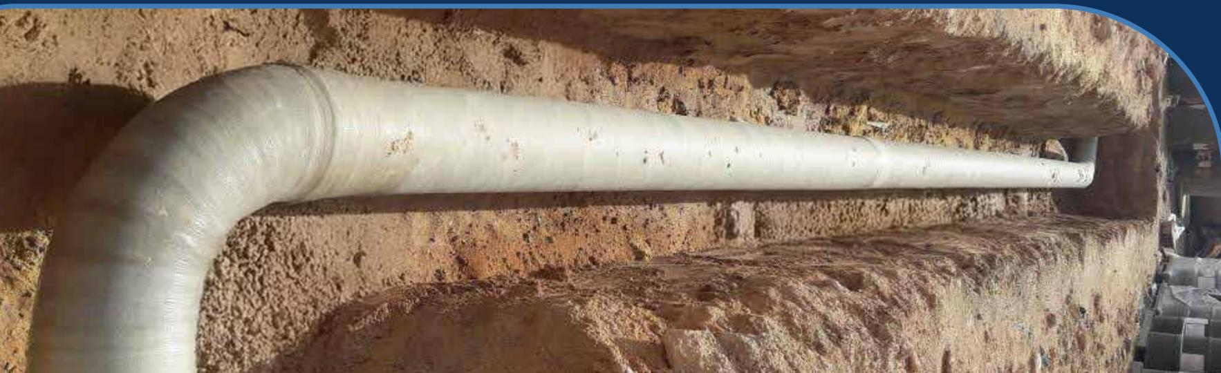
Dans le cadre de ce projet stratégique, CTRA a contribué au renouvellement du réseau de distribution d'eau de mer au sein de l'usine du Groupe Chimique Tunisien à Skhira. Ce projet visait à améliorer l'efficacité et la durabilité des installations industrielles en mettant en œuvre des solutions résistantes à la corrosion marine.
