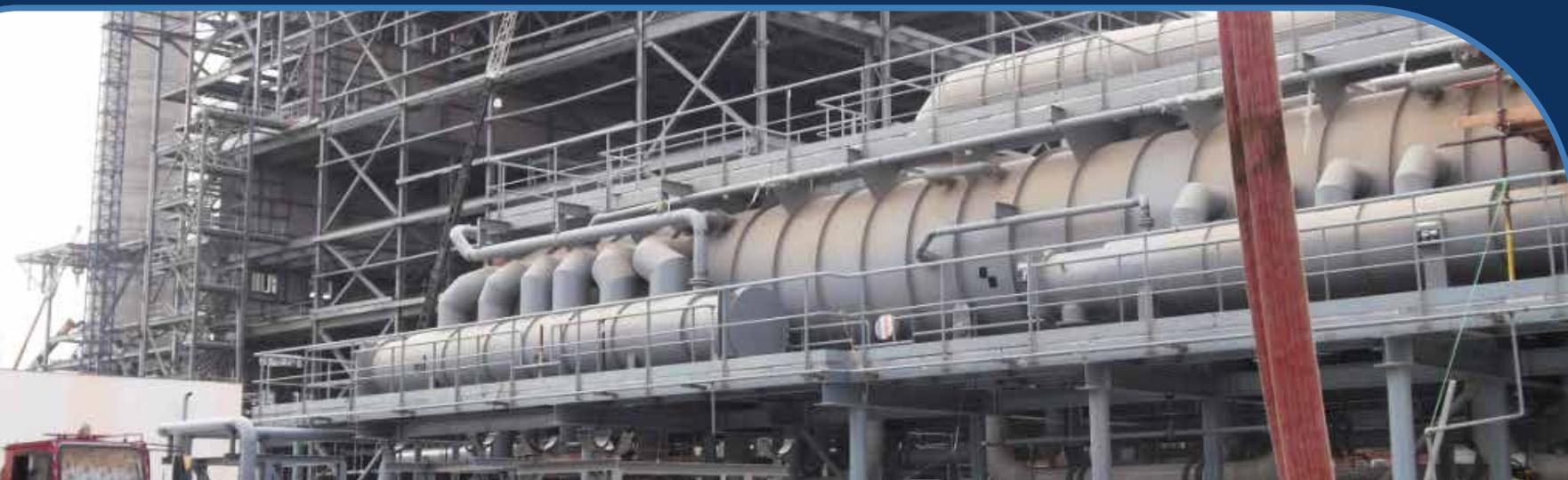
Dans le cadre de ce projet stratégique, CTRA a assuré la fabrication et la fourniture complètes du réseau de tuyauterie en PRV (GRP) destiné au Water Treatment & Chemical Injection Package de la centrale thermique supercritique d'El Ain Sokhna.
