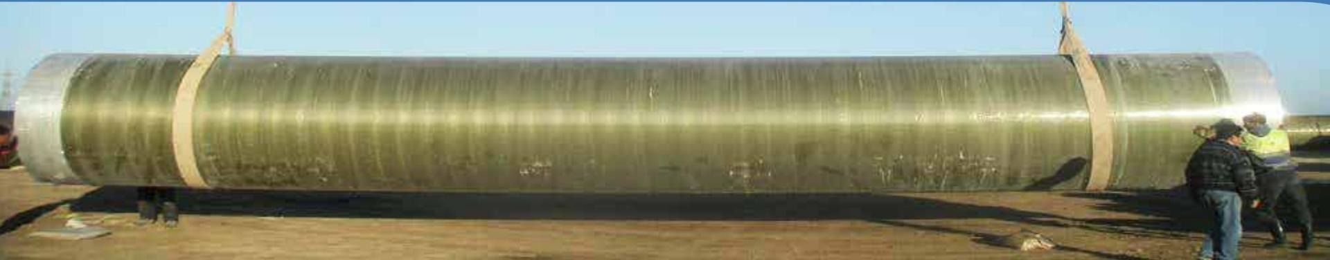
Dans le cadre du projet emblématique Maroc Phosphore III-IV, CTRA a réalisé une prestation clés en main pour la mise en place d'une file de rejet de phosphogypse. Ce projet d'envergure impliquait l'installation d'une conduite enterrée en SVR (Système Vinylester Renforcé) de grand diamètre (1800 mm), garantissant une résistance optimale aux contraintes chimiques et mécaniques du site industriel.
